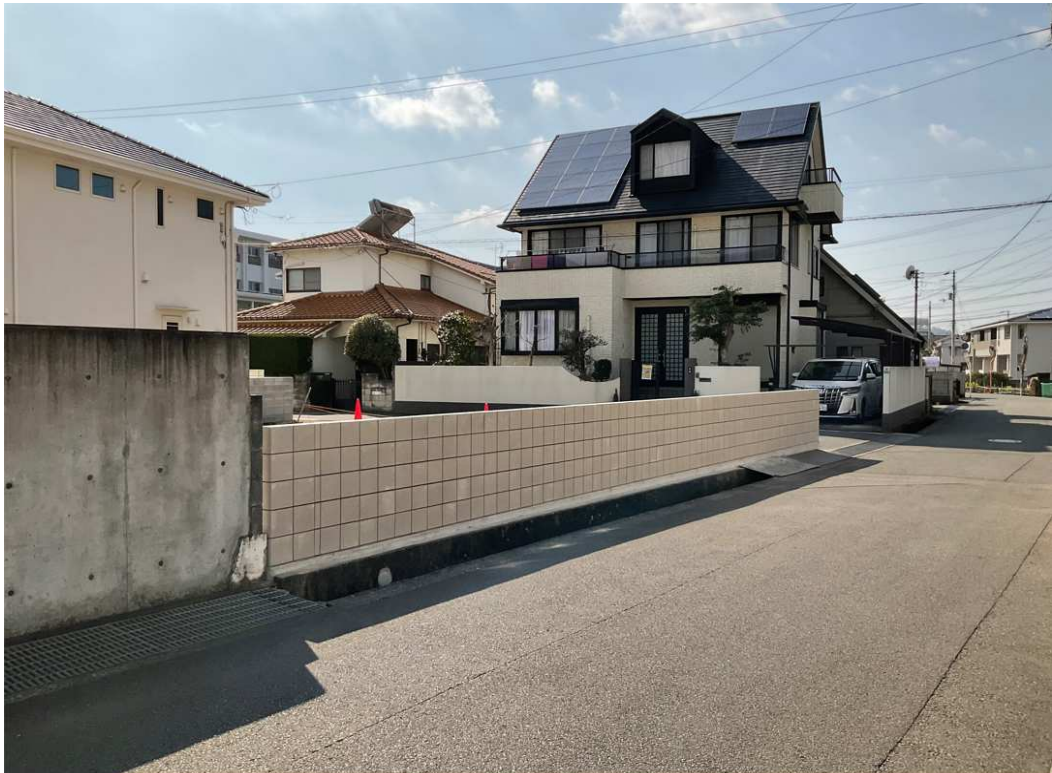
・物件北西方向から南東向きに撮影
